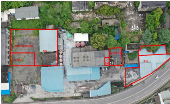
生产车间现状
