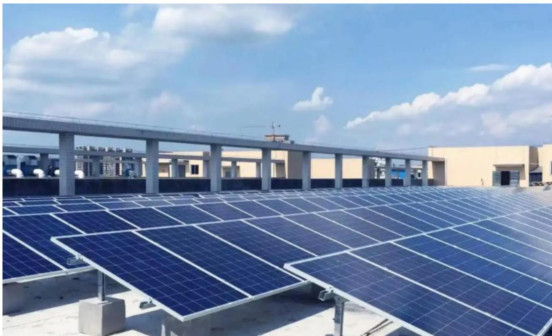
方案 D：工业厂房彩钢瓦钢结构式
