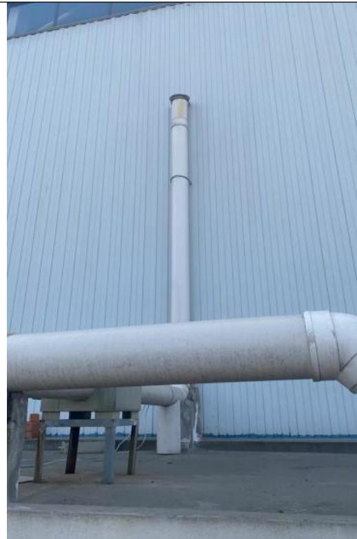
实验室楼顶排气筒 (DA004)
